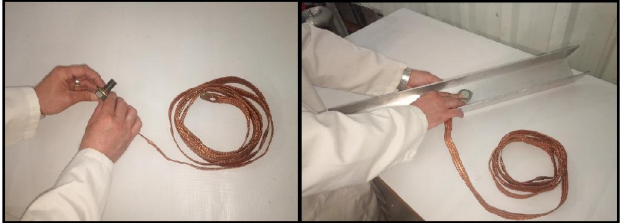
(a) Resim EK-4.2. (a) Topraklama iletkenine M16 cıvata ve pul bağlantısı (b) U kesitli metal iletkenine topraklama iletkenini alttan bağlantısı
